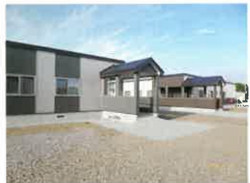
グ ル ー プ ホ ー ム ( 全 4 棟 )
